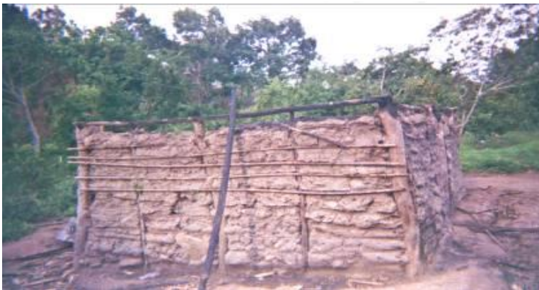
Fotografía vivienda afectada por la violencia
